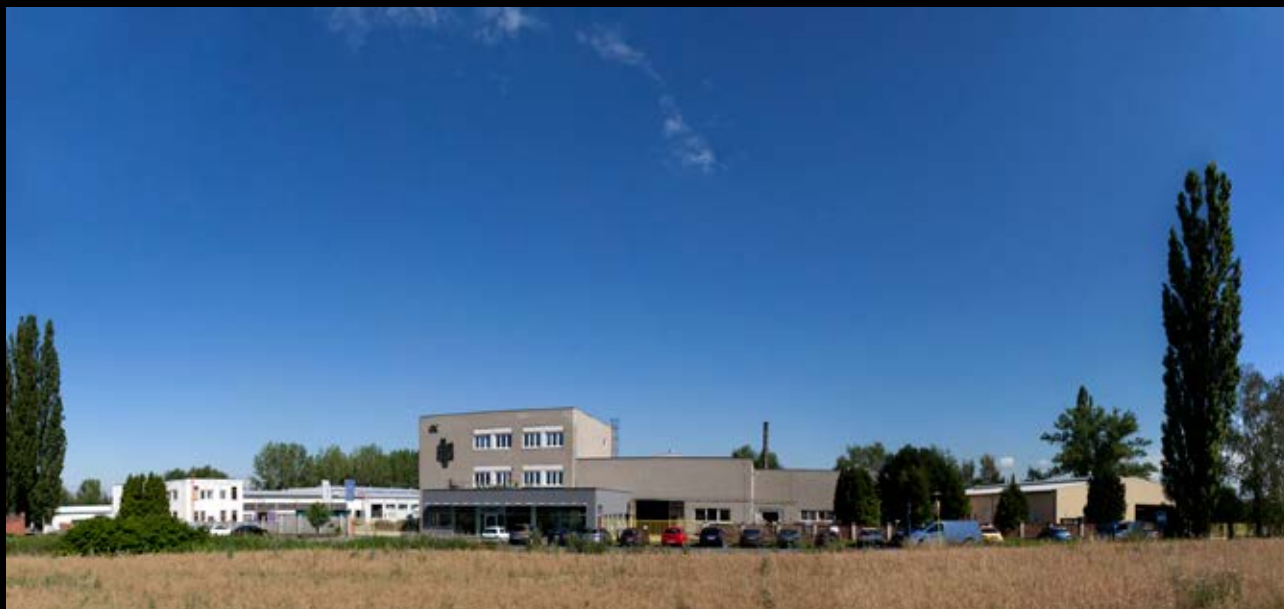
Pohled na správní a výrobní areál firmy J.A.P.
